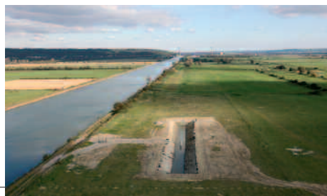
Techniques végétales protégées par un rideau de palplanches
