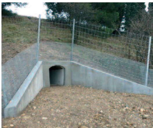
Achèvement d'un fonçage de diamètre 1200 mm
