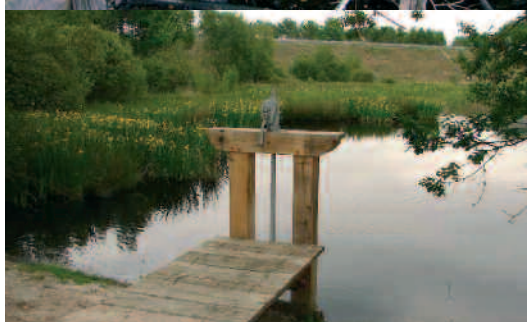
Nouvelle bonde mise en œuvre permettant la gestion des niveaux d'eau, crédit OGE
