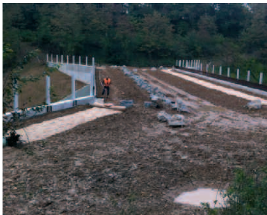
Chantier de l'éco-pont A7 (octobre 2011)
