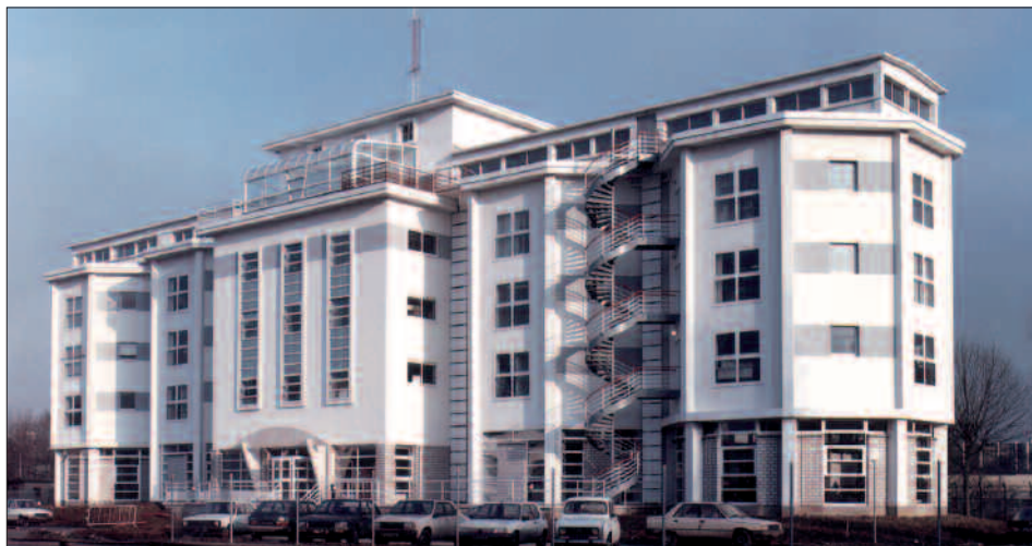
Silos à ciment construits en 1954, réhabilités en bureaux en 1988, en voie d'être réhabilités en logements en 2011 (2 500 m 2 habitables), Île-Saint-Denis, Paris, ©Bogaert'Architecture
