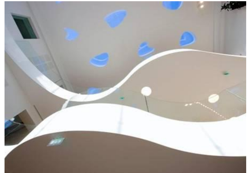
Huningue, France: toiture étanche en Ductal® pour les laboratoires Weleda
