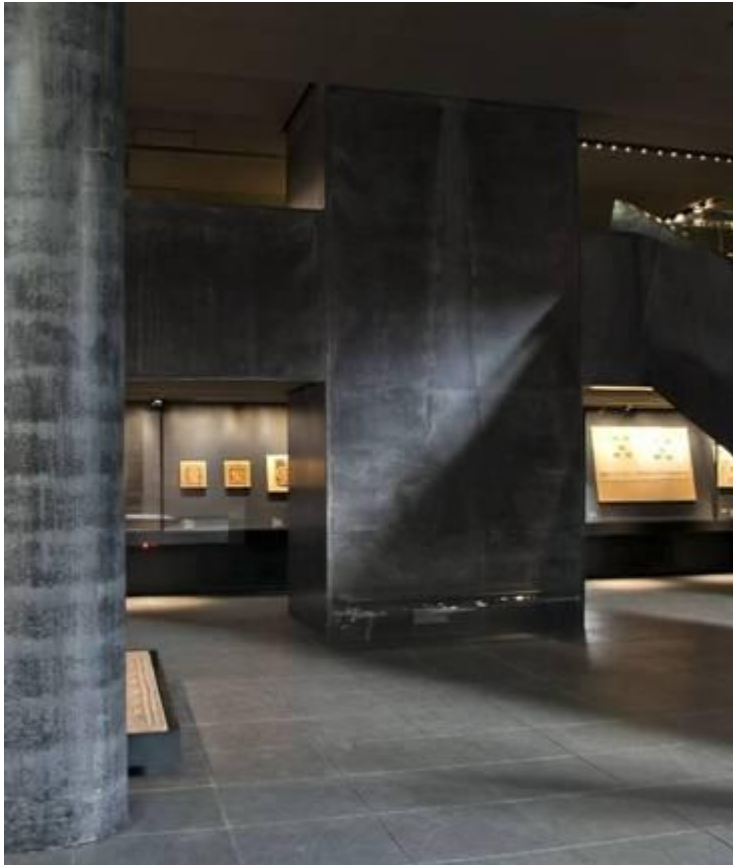
Paris, France : du béton fibré à ultra-hautes performances (Ductal®) et du béton Agilia® pour le nouveau département des Arts de l'Islam au Musée du Louvre.
