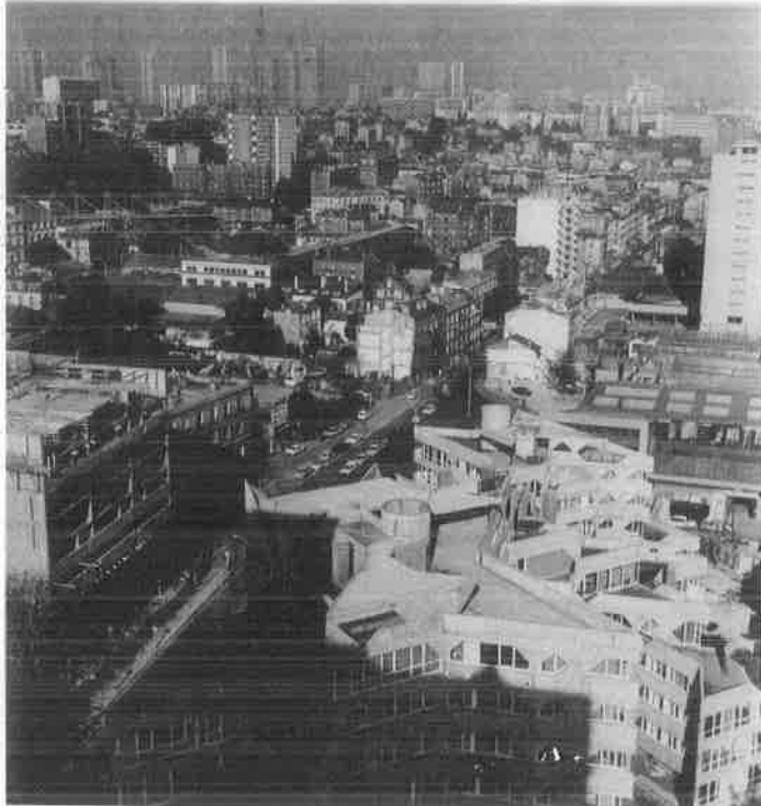
RENOVATION D'IVRY-SUR-SEINE (Arch. : J. Renaudie)
