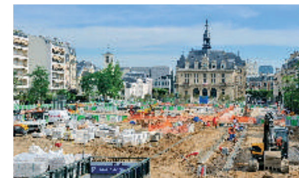
Réaménagement du Cours Marigny à Vincennes (RAZEL-BEC)
