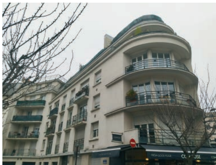
Neuilly-sur-Seine – Immeuble de logement social de faible hauteur, bien intégré dans le tissu urbain, mais offrant néanmoins une densité relativement élevée, avec un COS supérieur à 2.
